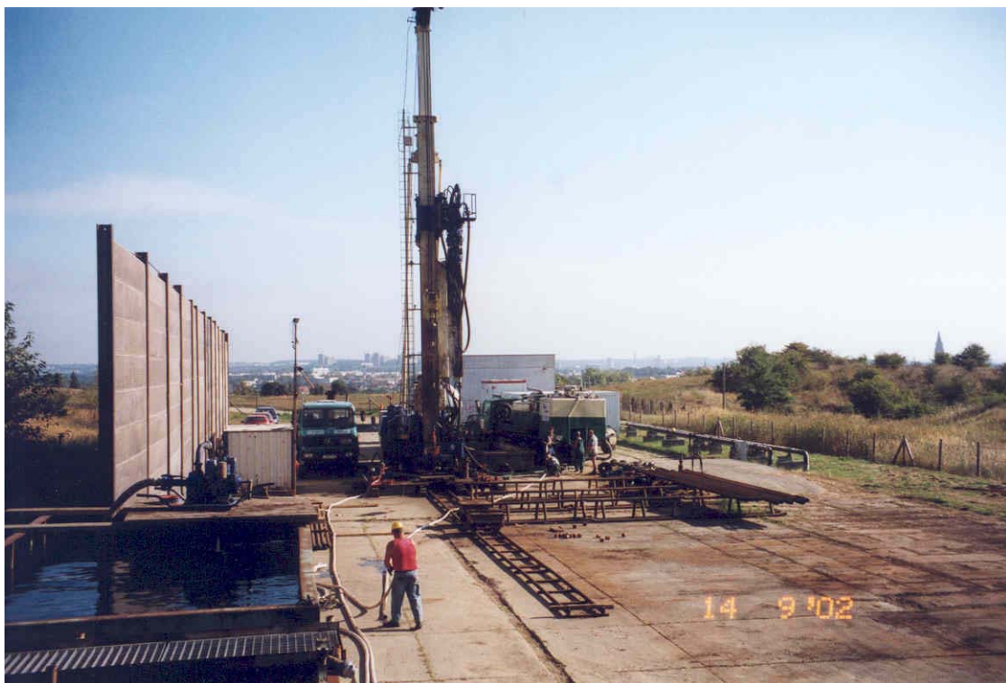
Bohranlage zur Aufwältigung und Uminstallation der Geothermiebohrungen Neubrandenburg
